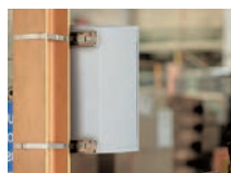
Шкаф Marina, установленный на вертикальный столб с суппортом Кат. № 0 364 48
